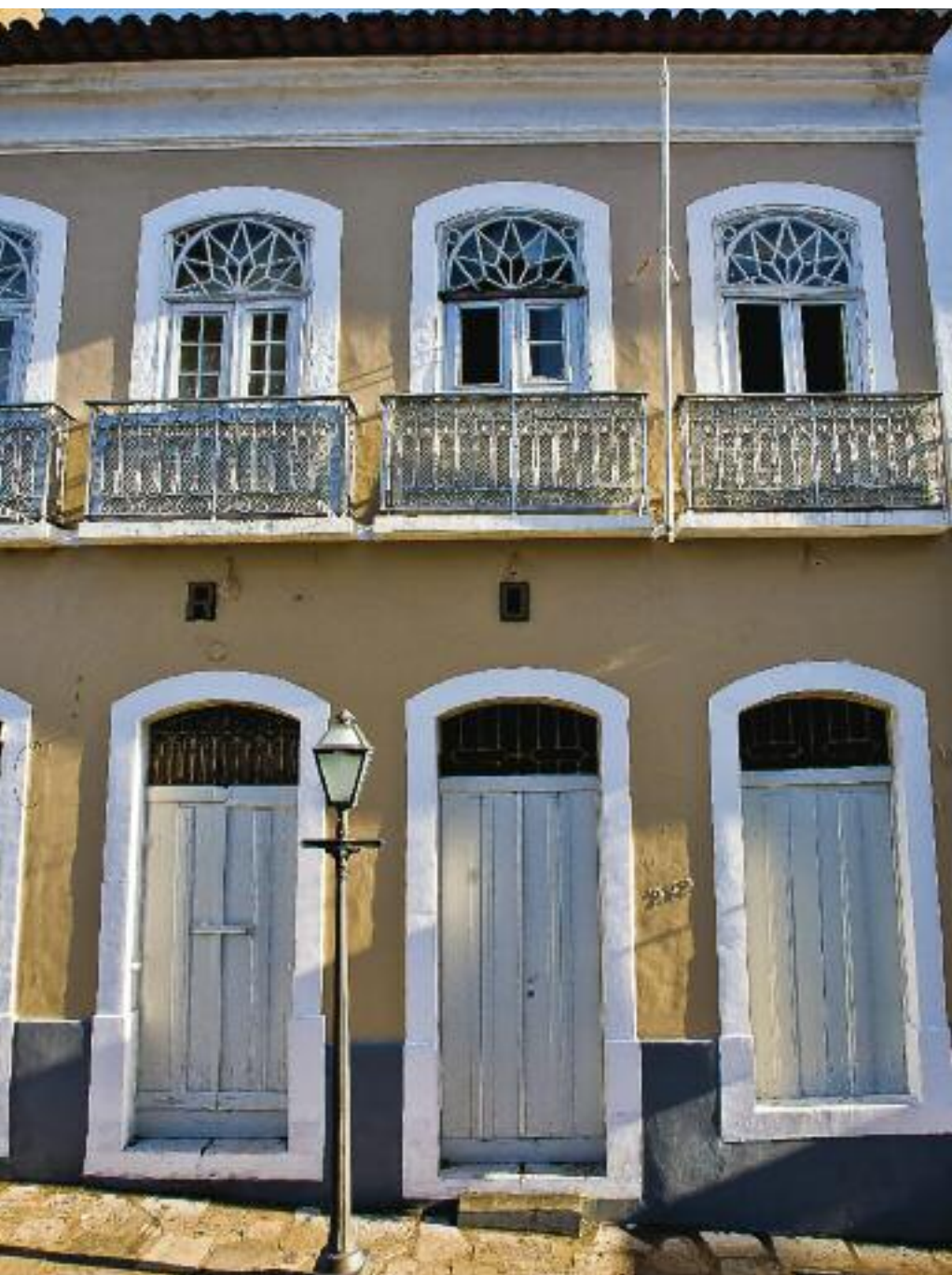
Portas de balcão guarnecidas de tapa-vista treliçado.
