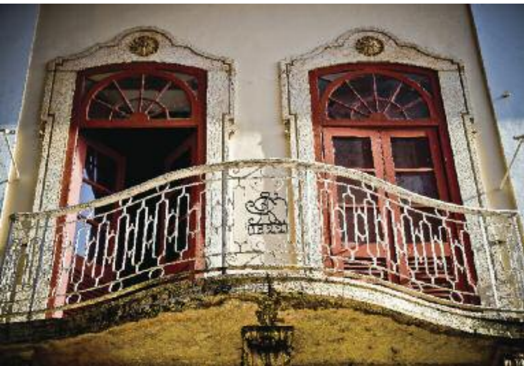
Balcão com data e iniciais do proprietário. Rua Joaquim Távora, 200. Balcony with date and the owner's initials. Joaquim Távora Street, 200.
