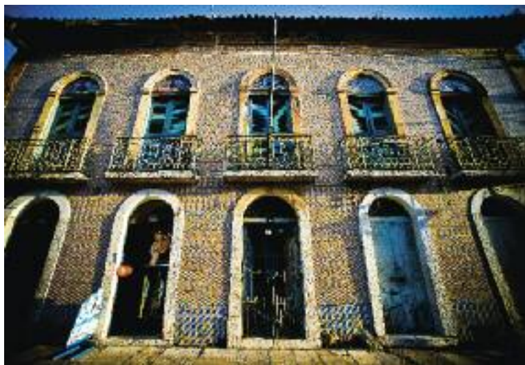
Fachada com azulejos do tipo enxaquetados. Rua 14 de Julho, 182. Façade with checkered azulejo tiles. 14 de Julho Street, 182.
