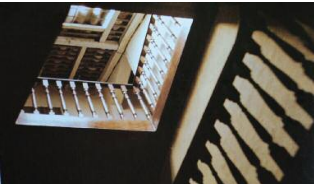
Escada de vestíbulo, destacando-se a balastrada de elementos torneados. Av. Pedro II, 199. Vestibule stairway with lathed balustrade. Pedro II Avenue, 199.
