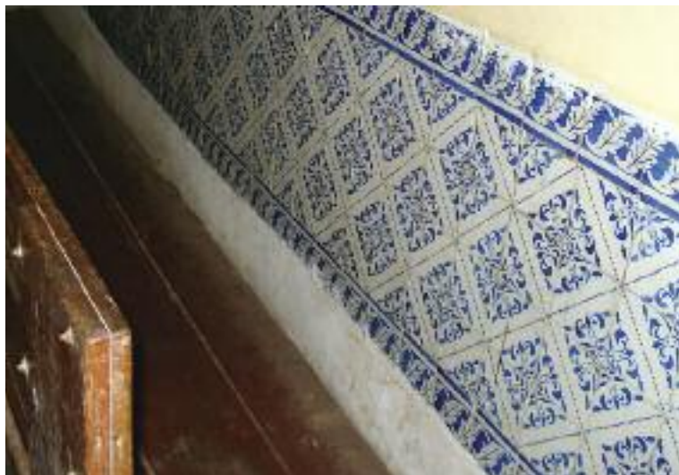
Barrado da caixa da escada. Rua Afonso Pena, 34. Bar in a stairwell. Afonso Pena Street, 34.
