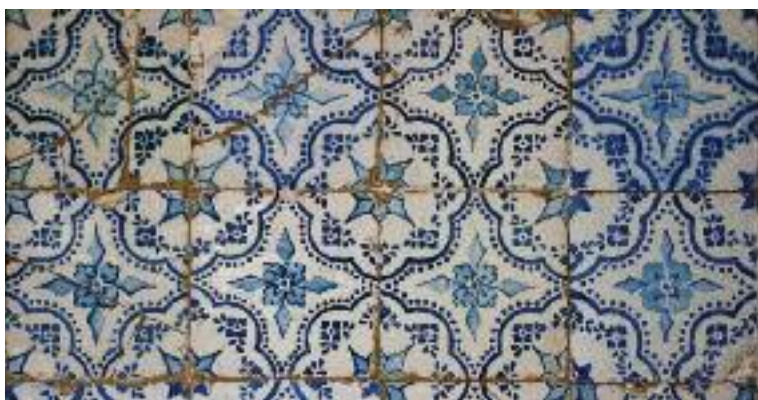
Fachada do tipo tapete.
