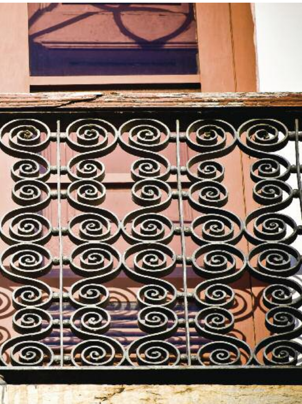
Gradil de balcão corrido.
