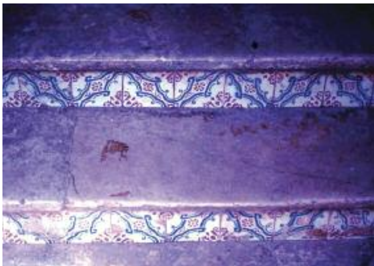
Piso de escada com espelhos de azulejo. Rua Joaquim Távora, 200.
