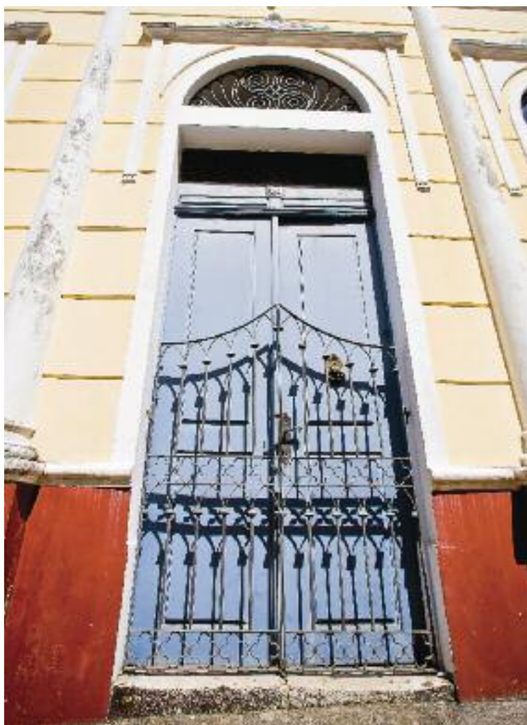
Cancela em porta de entrada. Rua do Giz, 394. Wicket at entrance door. Giz Street, 394.
