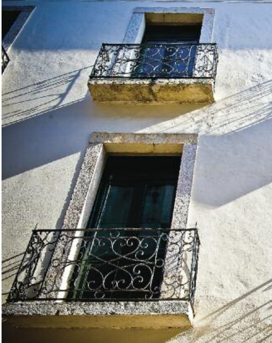
Superfície externa caiada de branco. Whitewashed external surface.
