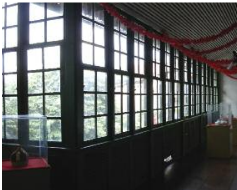
Varanda do sobrado da rua do Giz, 129. Veranda in a sobrado at Giz Street, 129.
