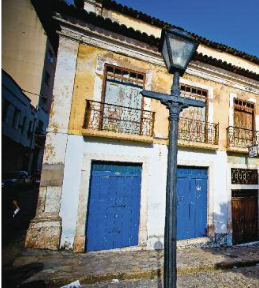
Sobrados da rua da Estrela. Sobrados on Estrela Street.
