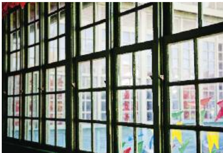
Guilhotinas da varanda. Sobrado da rua do Giz, 221. Hung sashes in the veranda. Sobrado at Giz Street, 221.
