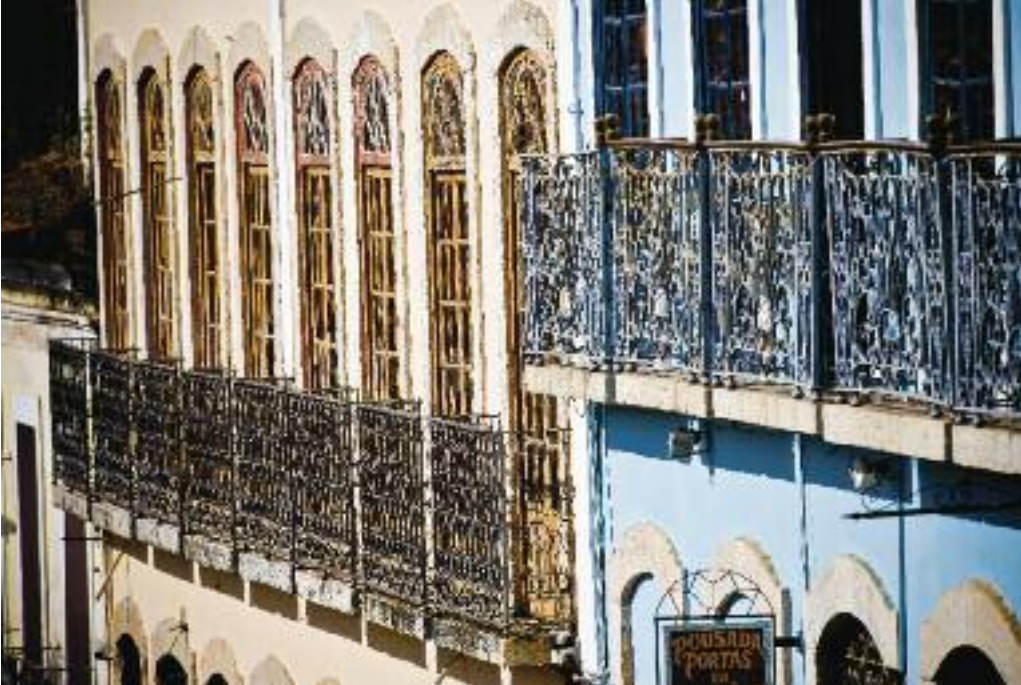
Aspectos das edificações da rua 28 de Julho. Aspect of buildings on 28 de Julho Street.
