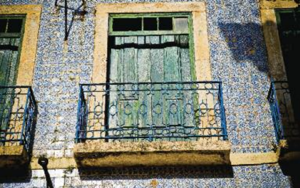
Superfície externa revestida de azulejo. Tile-coated external surface.
